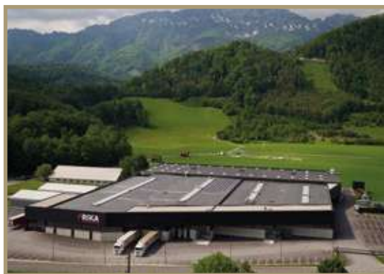
RIKA Entreprise de Métallurgie
